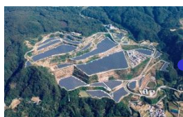
貴船太陽光発電所
