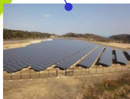
くろすみ太陽光発電所
