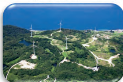
淡路市野島地区 (2000 kw × 6 基)
