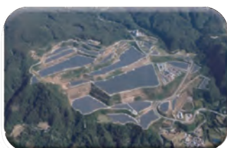
淡路市野島貴船地区 (30MW)
