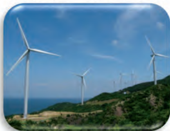
南あわじ市阿那賀地区 (2500 kw × 15 基)
