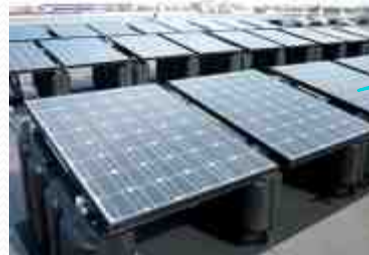
貯水タンク併設型ソーラー発電
